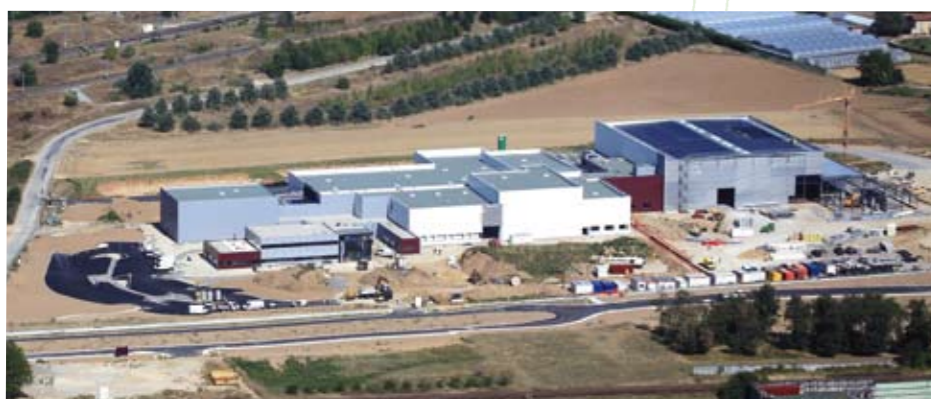
Bâtiment BOIRON Frères en cours de construction.
